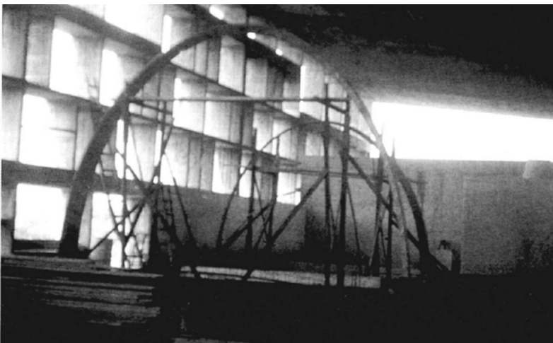
Imágenes 18, 19 y 20. Construcción de la sala de música.
