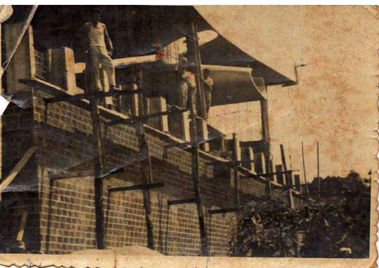
Imagen 14. y 15. Construcción del goterón de hormigón armado.
