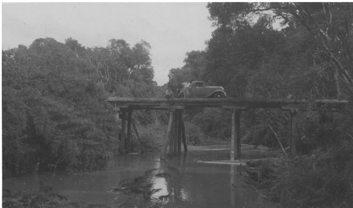
Imagen 2. Puente sobre arroyo Yacuy, 1938.
