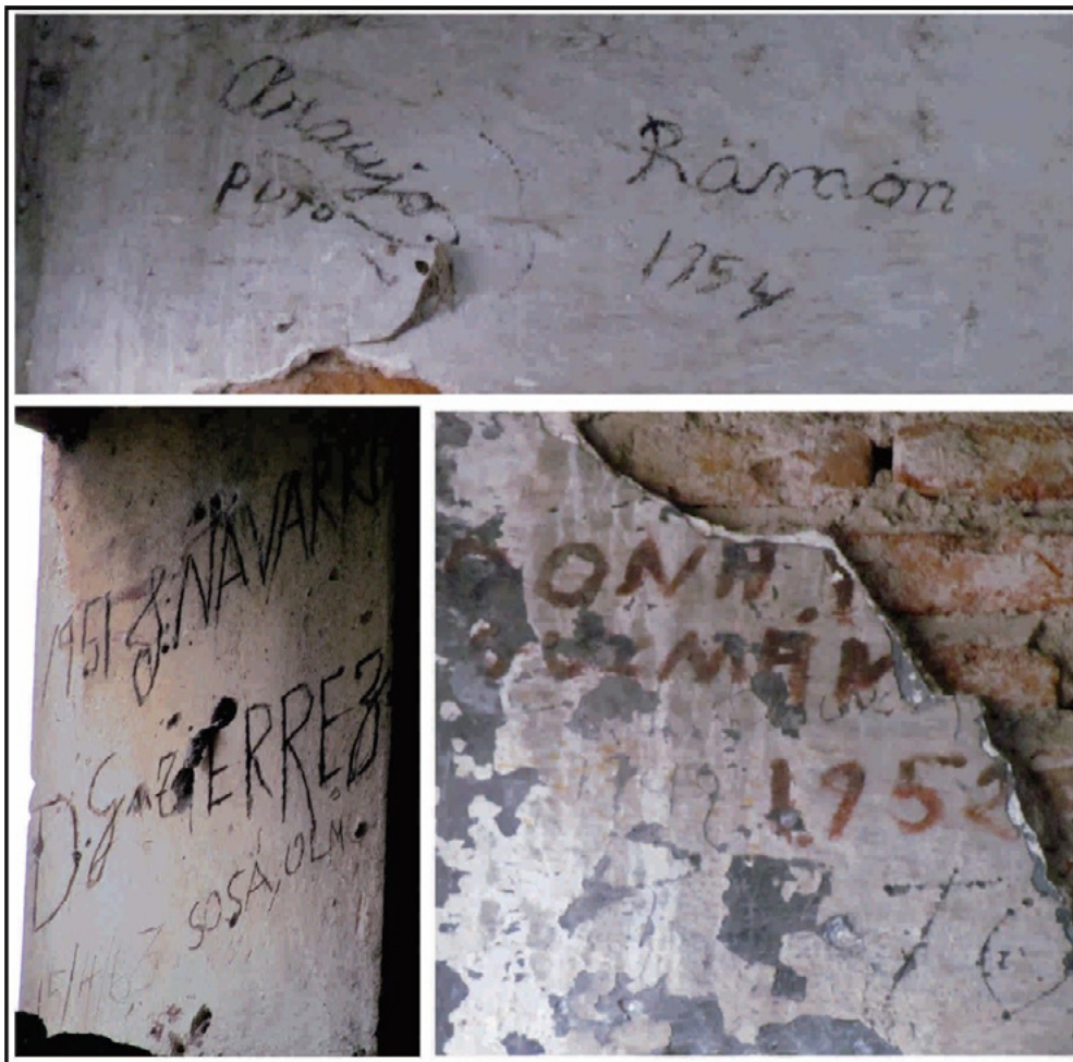
Figura 5. Graffiti relevados en el salón de destilería del Ingenio Lastenia.
